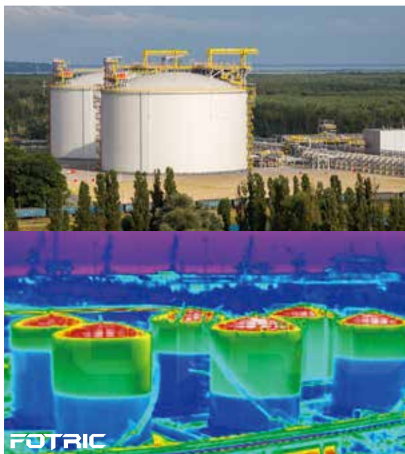
储罐防火监测
