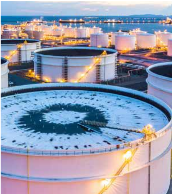
危化品储罐区
