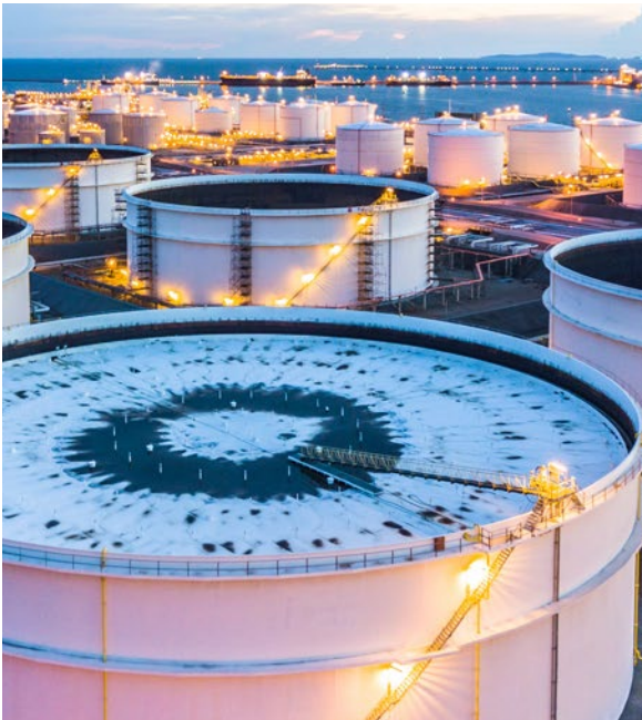
危化品储罐区
