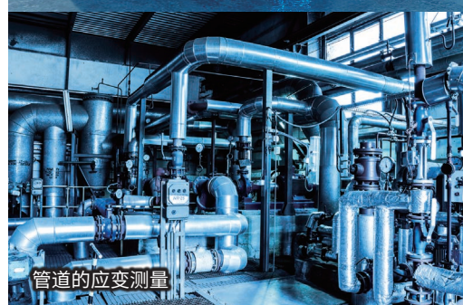
制动和配管的应变测量
